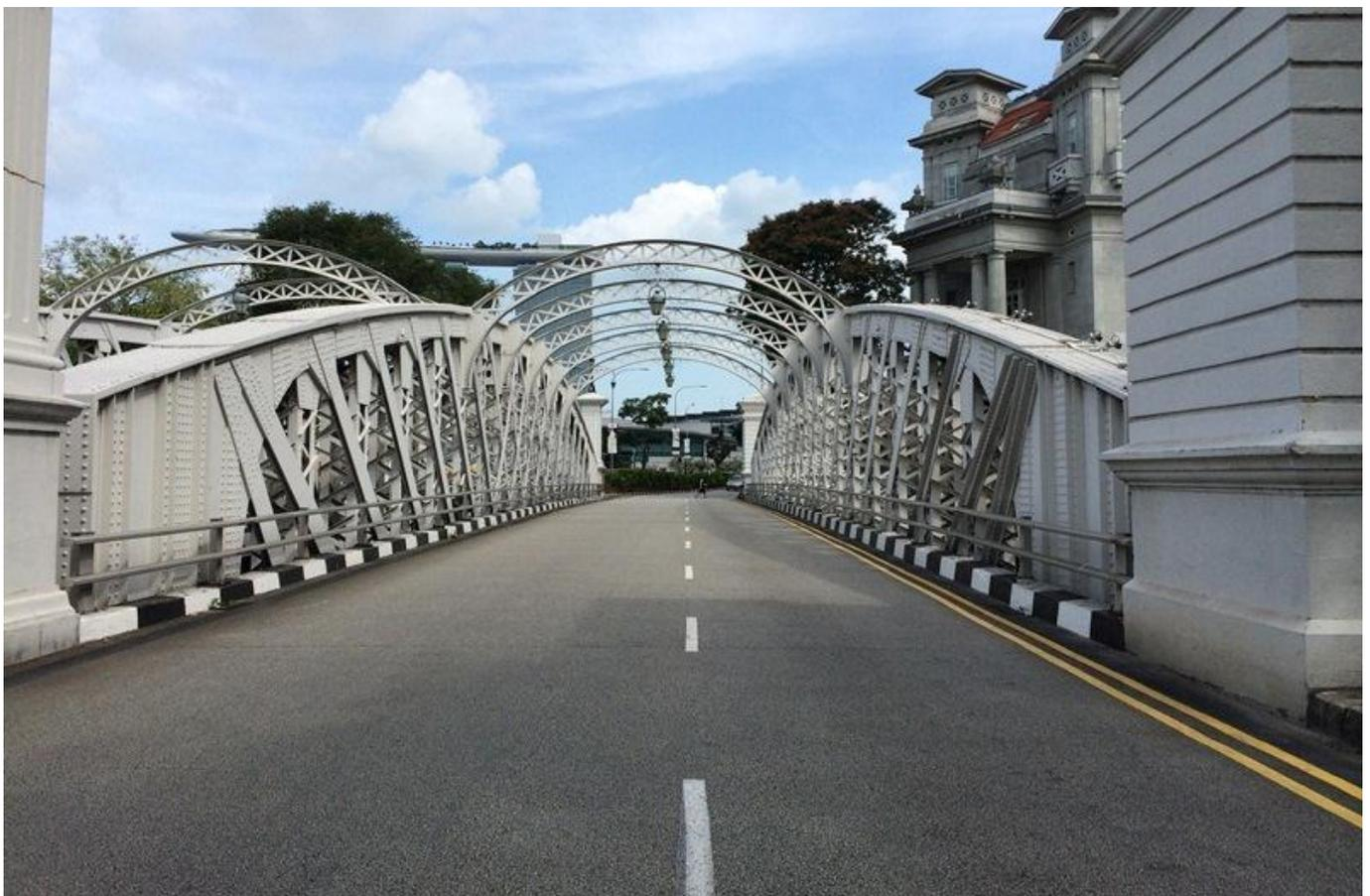
Das ist die Anderson Bridge. Eine von mehreren Metallbrücken, die im 19. Bzw. frühen 20. Jahrhundert entstanden. Wie viele Brücken dieser Zeit, wurde auch diese zu niedrig über den Fluss montiert und damit zu einem Hindernis für den Warentransport auf dem Wasserweg.
