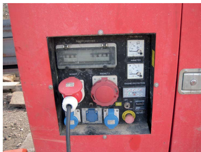
Abb. 15: Stromerzeuger im Baustelleneinsatz mit „eingebauter Baustromverteilung“
