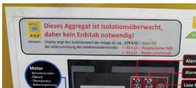
Abb. 14: Irreführender Aufkleber auf Stromerzeuger
