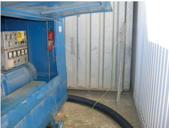
Abb. 17: funktionsunfähige Erdung eines Stromerzeugers
