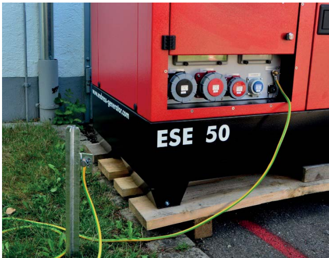
Abb. 16: Ausführungsbeispiel eines Erdungsanschlusses eines „großen“ Stromerzeugers
